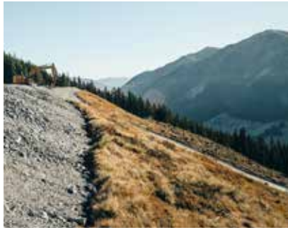
Übersiedelte Grasziegel (Wasen) am neuen Außendamm Speicherteich Rosswald.
